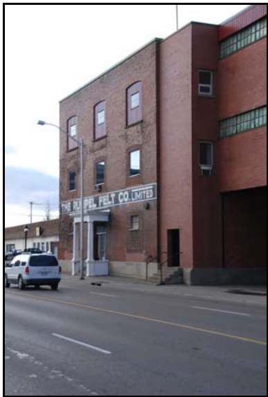
Fig. 29 Victoria Street N. façade
