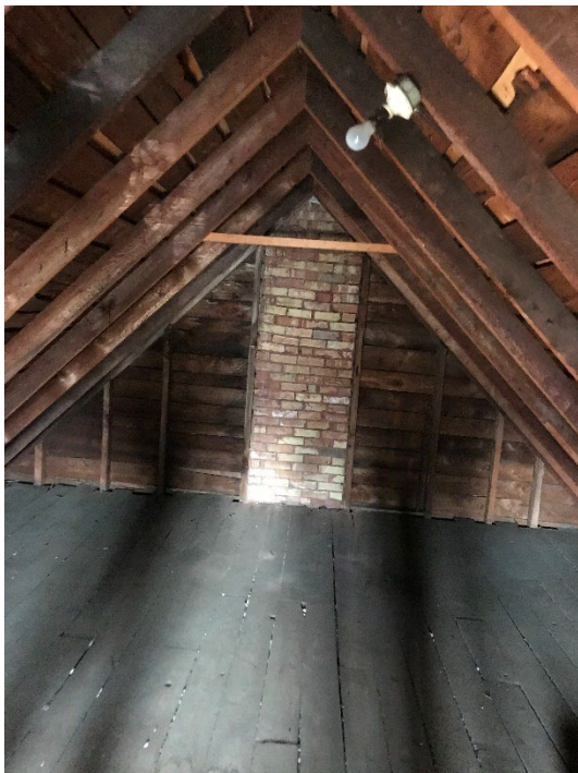
Existing chimney – Interior.
