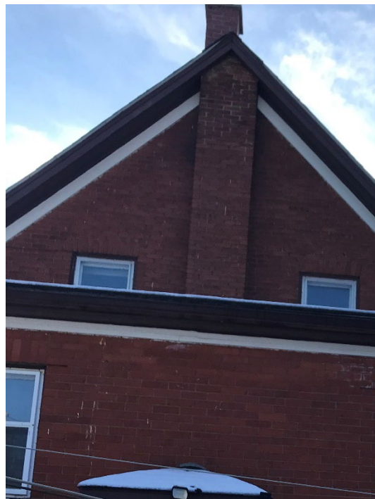
Existing chimney – Exterior.
