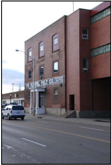
Fig. 29 Victoria Street N. façade
